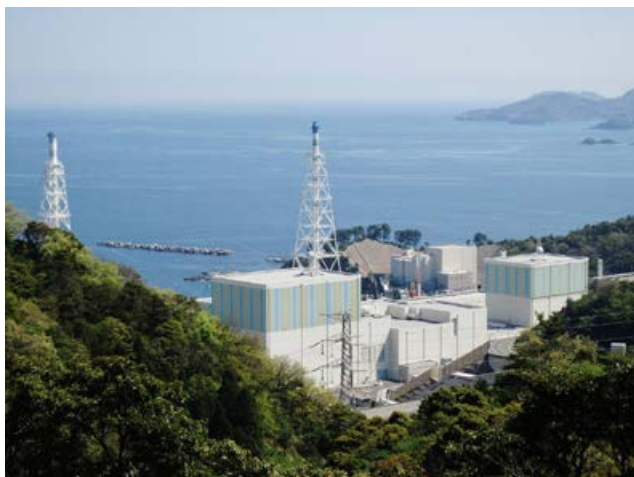
島根原子力発電所
